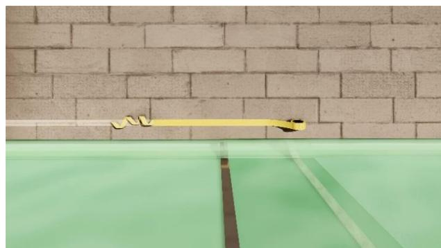
5. Poser l'adhésif double-face sur le pied du mur et installer les relevés de film anti-radon en prenant soin de bien maroufler pour éviter la formation de pli.
