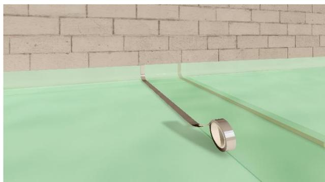
4. Poser l'adhésif raccord\* afin de bloquer et sécuriser le bord du recouvrement, puis maroufler en évitant la formation de pli.
