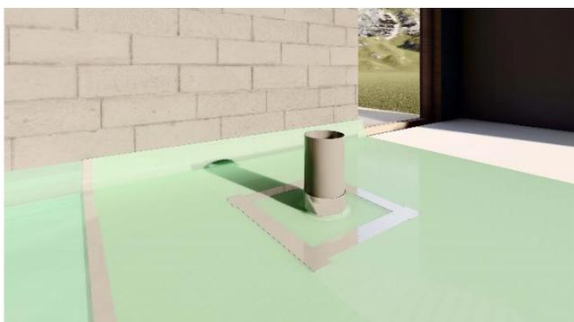
3. Appliquer l'adhésif raccord\* afin de sécuriser les raccordements entre le film anti-radon, l'embase et le tube.
