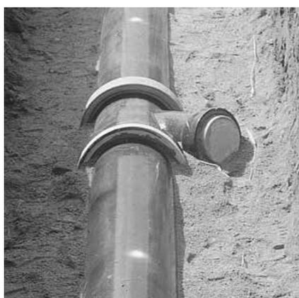
Les tuyaux en grès doivent être posés de manière à ce que leur fût ait un appui régulier et qu'ils soient disposés au milieu de la tranchée. Pour les collets, il faut prévoir des cavités adaptées.
