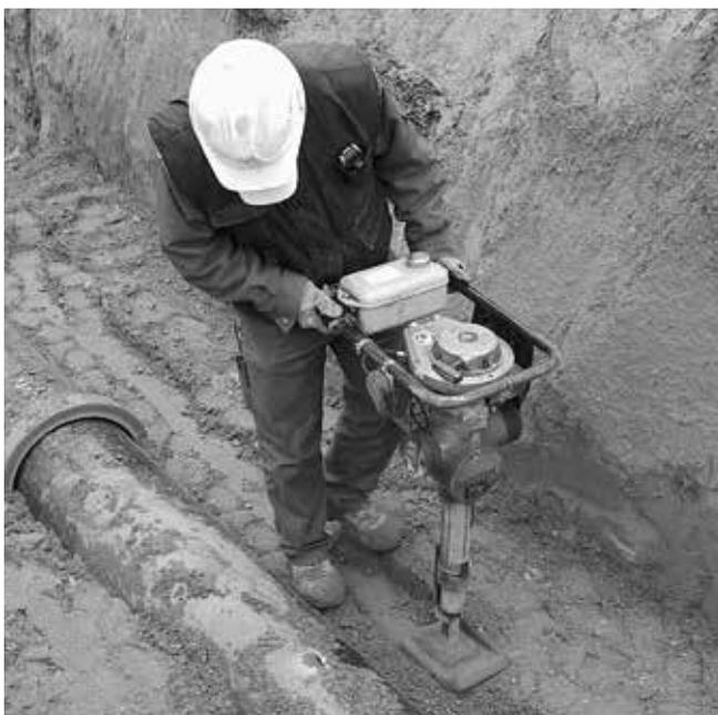
Le compactage mécanique est réalisé par couches de 15 à 30 cm. L'emploi d'appareils compacteurs de poids moyen à lourd au-dessus du tuyau est autorisé uniquement à partir d'une épaisseur de remblai et de revêtement d'au moins 1 m.
