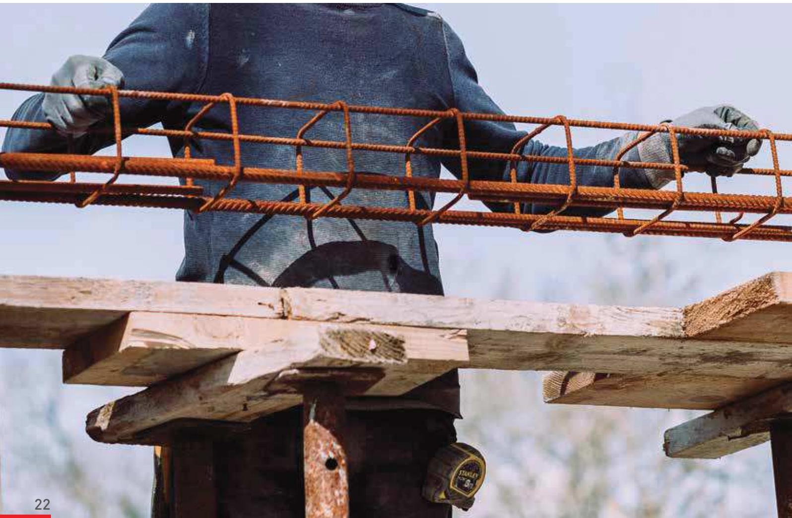
• Chaînages horizontaux renforcés au niveau des planchers - terrasses (CHR) ; Raidisseurs verticaux (R).
