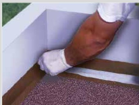
2- Collage de l'armature de renfort **Alsan® Voile Flashing** (développé 10 cm) à l'aide d'**Alsan® Flashing** (500 g/m<sup>2</sup>).
