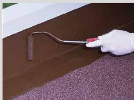
4- Application de la 2<sup>ème</sup> couche d'**Alsan® Flashing** (700 g/m<sup>2</sup>).
