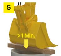
5 Exercer une pression verticale maintenue durant au moins **une minute** avant remblaiement
