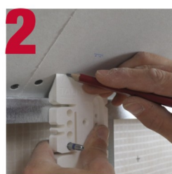
2 Biseau pour tracer/ mesure plaque sous rampants.
