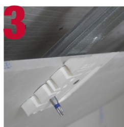
3 Maintien de la plaque en pose rampant
